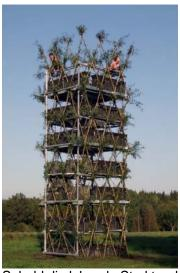
Sobald die lebende Struktur des Baubotanik-Turms stabil genug ist, um die drei einwachsenden Ebenen aus verzinktem Stahl zu tragen, wird das Gerüst entfernt. Foto: Universität Stuttgart
